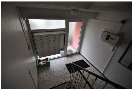
Briefkastenanlage mit Eingangsbereich
