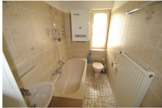
Badezimmer mit Gasetagenheizung
