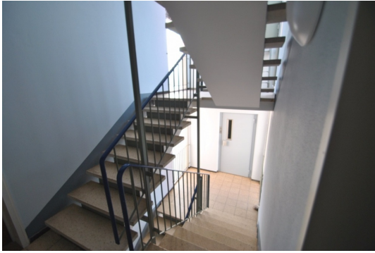
Treppenhaus mit Aufzug
