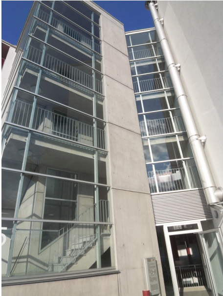
Aufwendige bauliche Gestaltung
