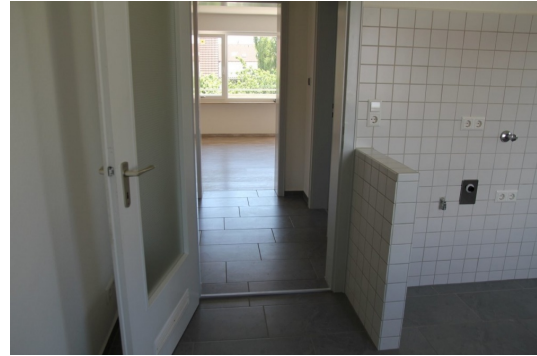
Küche Anschlüsse Waschmaschine und Trockner
