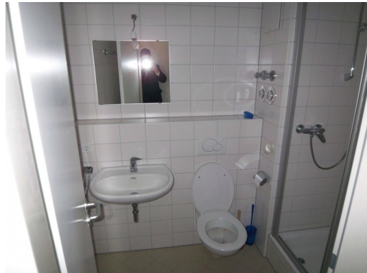
Abb. ähnlich Fußbodenheizung auch im Badezimmer
