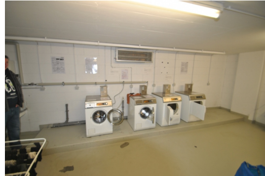
Wasch- und Trockenraum
