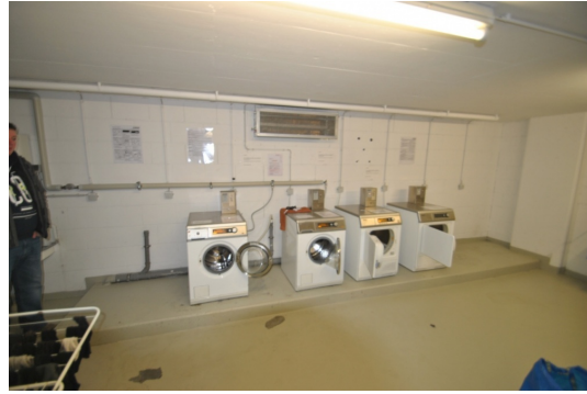
Wash- und Trockenraum
