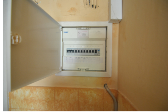
Leitungen liegen teilweise Aufputz
