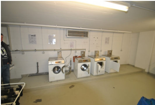
Wasch- und Trockenraum
