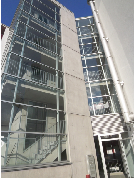
Aufwendige bauliche Gestaltung
